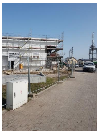
Abbildung 2: Stromverteilerkasten ggü. Landhandel. Aufnahmedatum: 23.02.2021
