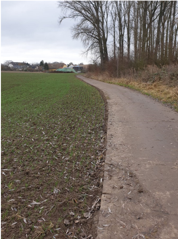
Abbildung 2: Bei diesem Betonweg Richtung "Bruch" wurde nahezu auf der gesamten Länge des Weges das vorgeschriebene, 50 cm breite Bankett „abgepflügt“. Das Wegesfundament hat an diesen Stellen bereits erheblichen Schaden genommen und die vorgesehene Funktion ist nicht mehr gewährleistet
