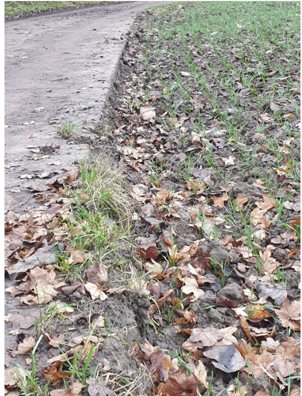
Abbildung 2: Bei diesem Betonweg Richtung "Bruch" wurde nahezu auf der gesamten Länge des Weges das vorgeschriebene, 50 cm breite Bankett „abgepflügt“. Das Wegesfundament hat an diesen Stellen bereits erheblichen Schaden genommen und die vorgesehene Funktion ist nicht mehr gewährleistet
